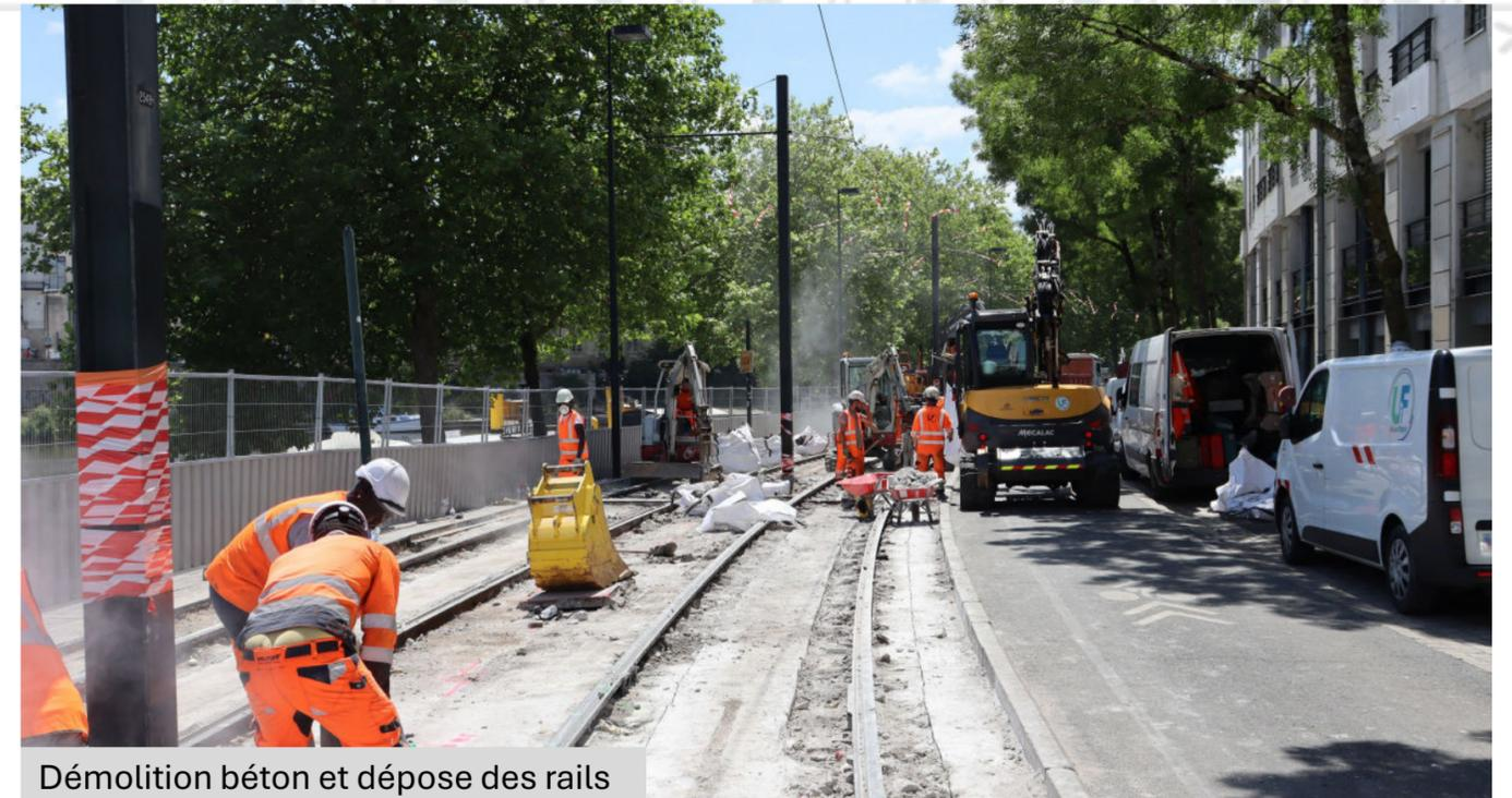
Démolition béton et dépose des rails
